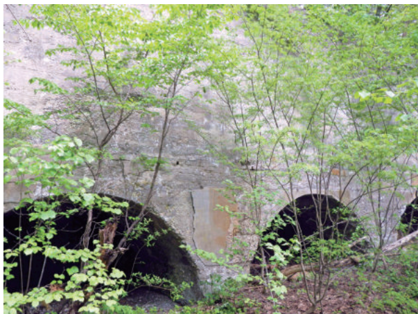
写真4 1段目構造物の南西面西側のトンネル
