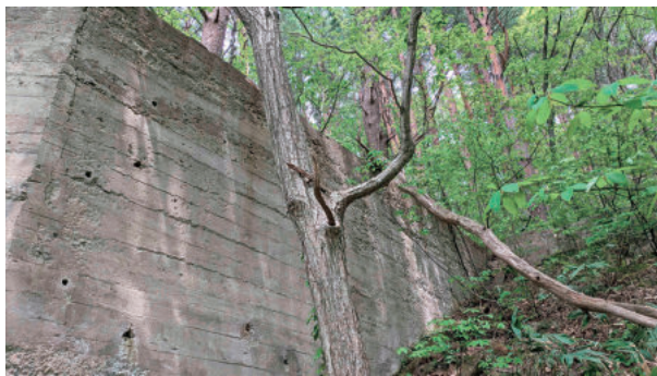
写真1 1段目構造物外側（南東側）
