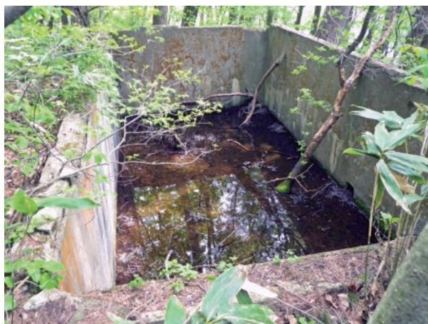
写真6 1段目構造物北東隣の貯水槽と思われる構造物
