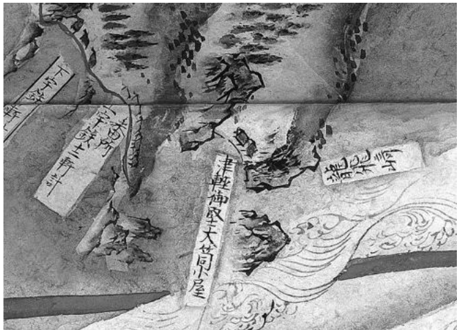
写真5 龍飛崎の大筒小屋
