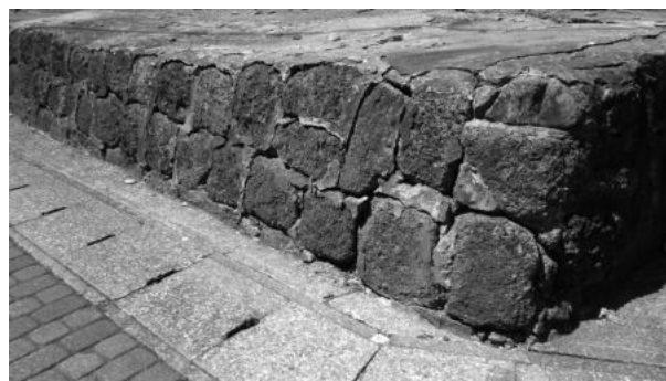
図2 九艘泊石製の土留（九艘泊地区）
