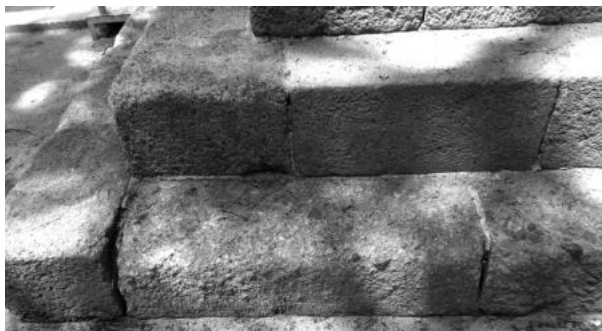
図6 一部に九艘泊石を使っている土台の石段（川内八幡宮）
