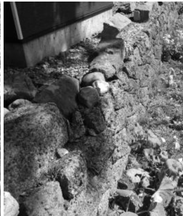
図5 九艘泊石製の土留（蛸崎八幡宮）
