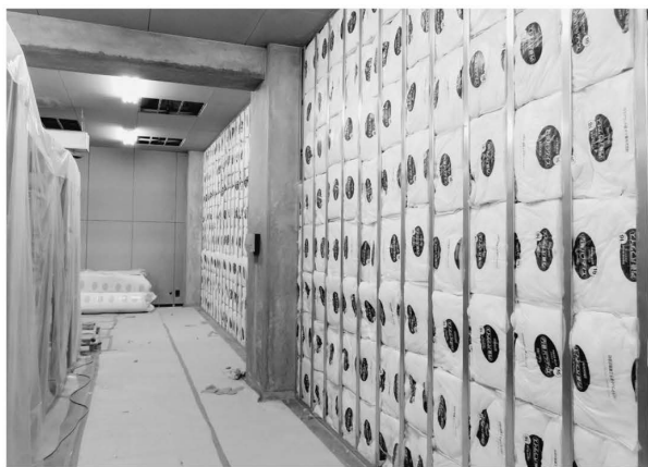
6 新たな断熱材を充填
