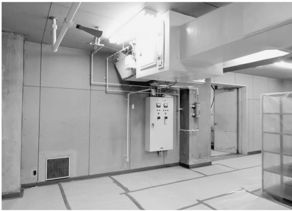
1 改修前の養生
