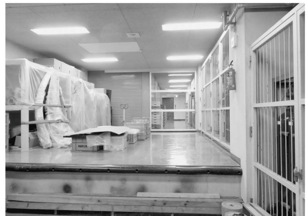
写真9 バックヤード改修後の現状(平成31年1月)
