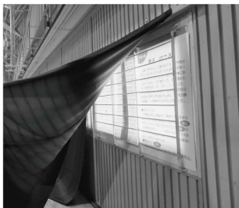
写真4 体育館窓ガラスの養生
